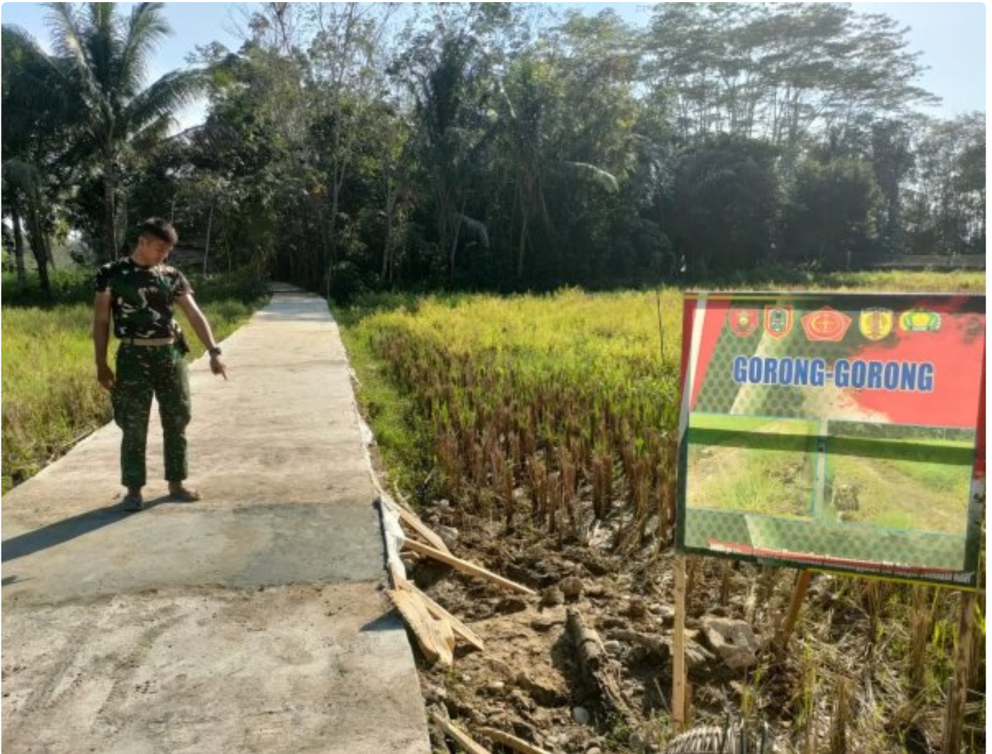
Sasaran Fisik Gorong-gorong 1 TMMD Ke-116 Kodim 1002/HST Rampung 100 Persen
