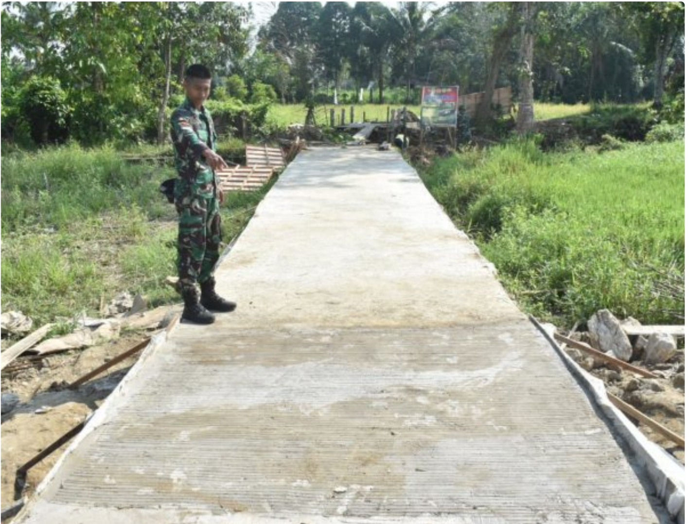
Gorong-gorong dan Slop Beton Ramping Seratus Persen
